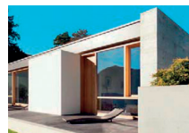
Maisons individuelles Einfamilienhaus
